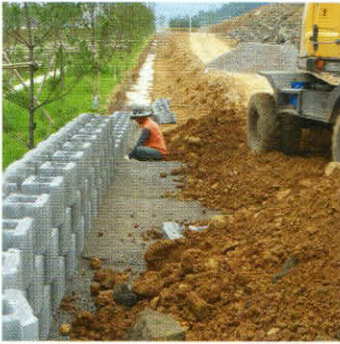
▲ 기초 터파기 및 다짐
